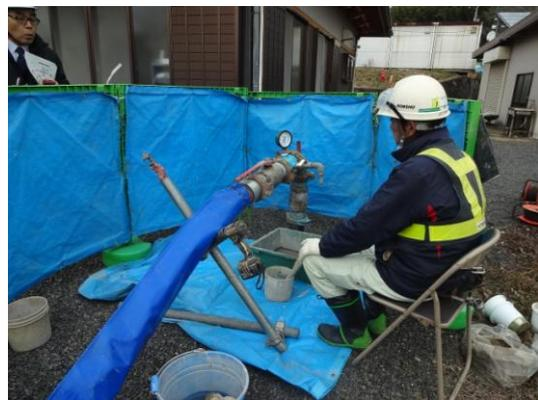
↑一般住宅敷地内で実施されていた充てん作業。圧力計にて進捗を確認しながらの作業。充填が完了に近づくると充填孔部分で、押し戻しの圧力が生ずる。そのモニタリングを行いながら慎重に行う。
