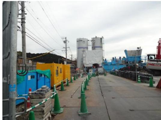
↑ プラント全景、右写真：右側の四角い部分でキラ材を細かく砕く。円柱状のタンクは、固化材のサイロ。
